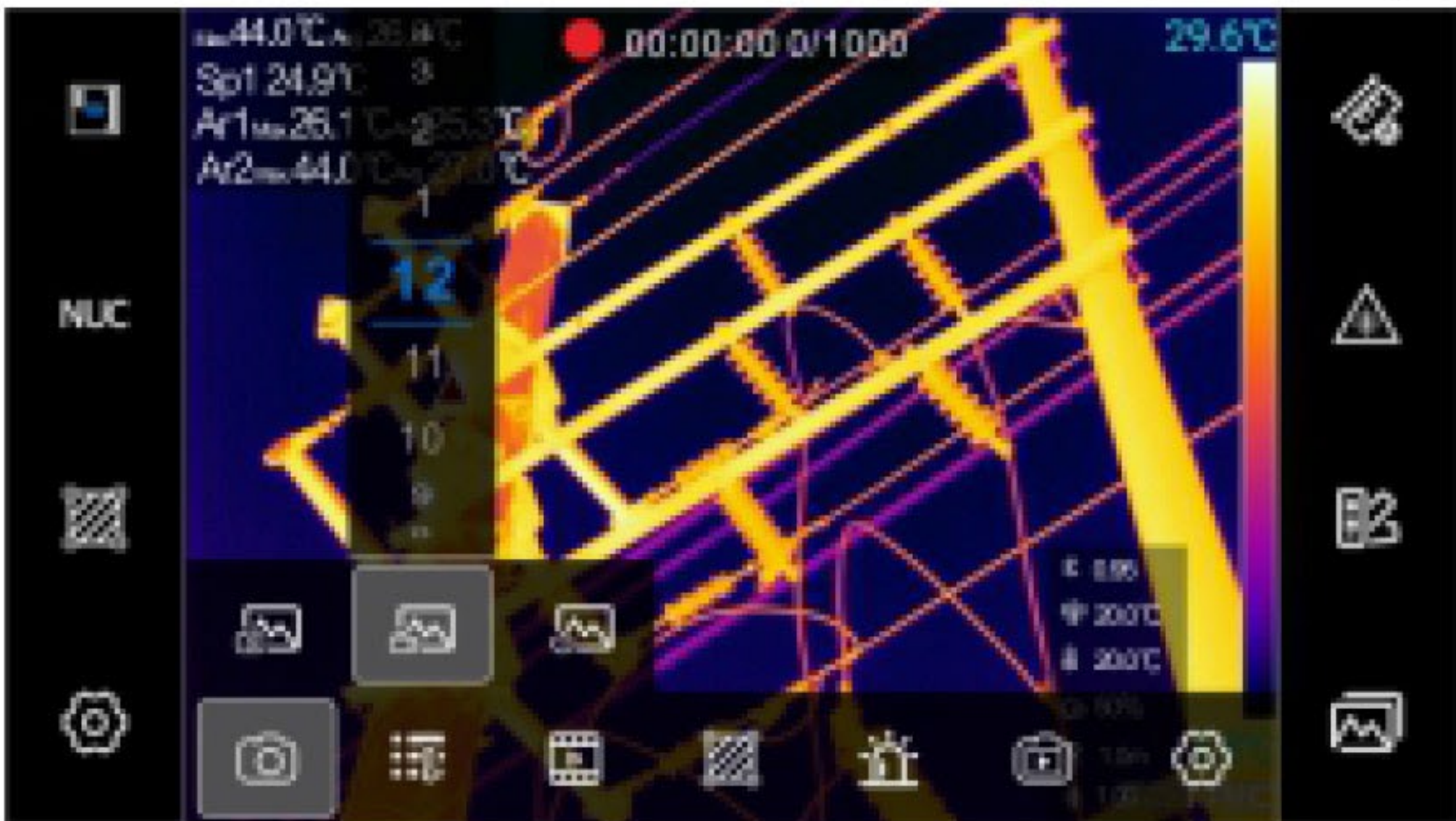
本机全辐射热像小视频录制
